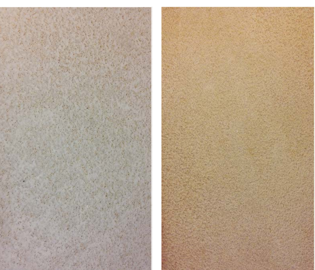
RIVESTIMENTO DEL MANUFATTO IN CALCESTRUZZO
