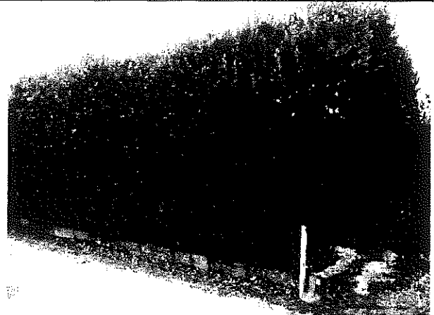
Vista della siepe di delimitazione
