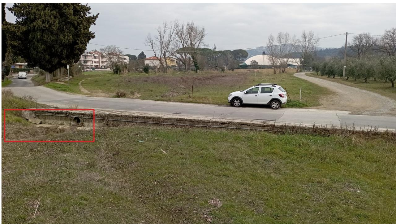
*Figura 2.3: sezione a valle del guado, nel riquadro rosso è evidenziato lo scavo provocato dalla corrente in uscita dal tombino esistente*
