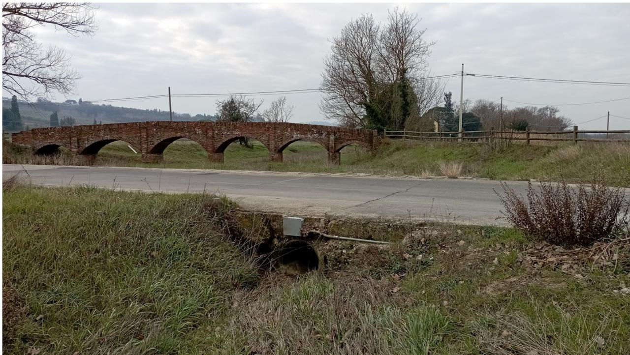
*Figura 2.4: imbocco del tombino al di sotto del guado*
